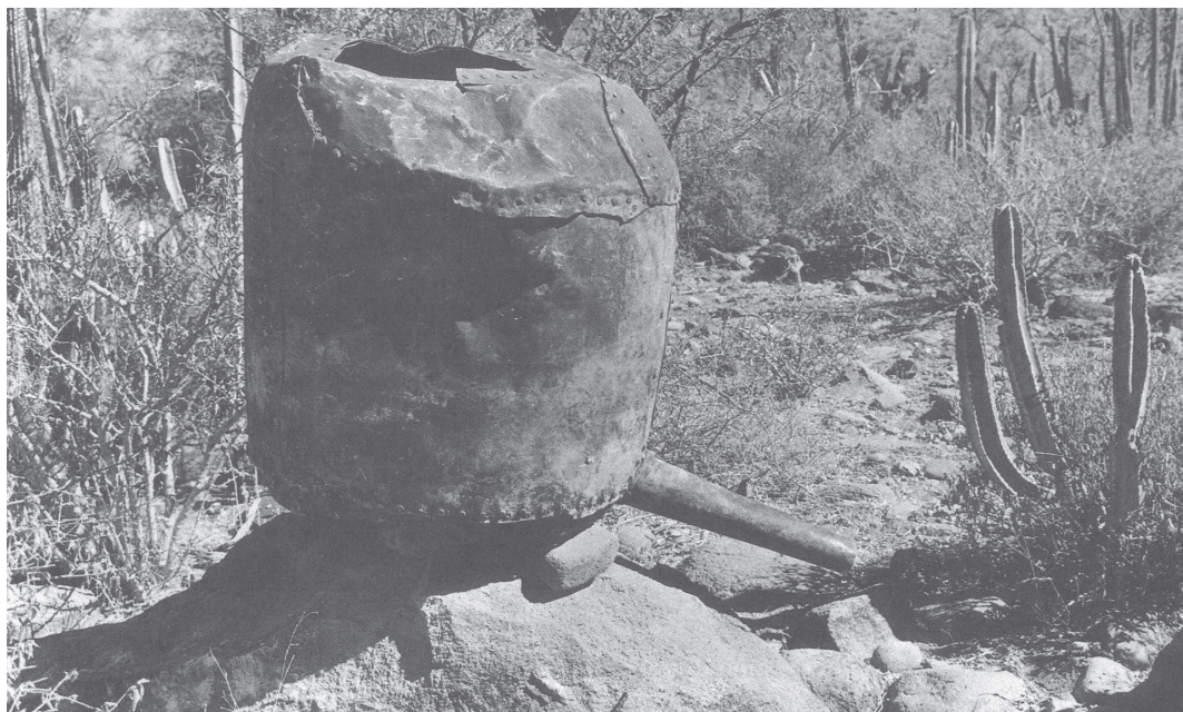
Una funda de condensación para el destilado del mezcal. Los que elaboraron esta bebida mandaron construir todo su equipo de fermentación y destilación de vistosas y pesadas planchas de cobre.
