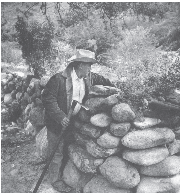
Loreto Arce limpia la tierra y las hojas de su sistema abierto de irrigación, aquí elevado sobre un muro de piedra para mantener su gradual caída desde el distante manantial.
